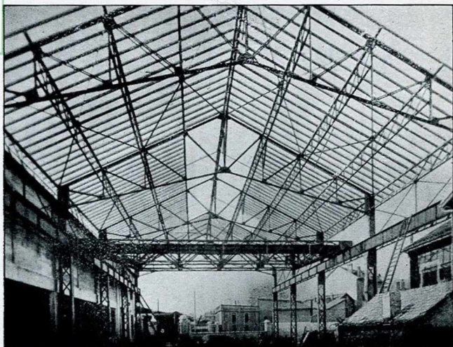
Charpente métallique Pont roulant
